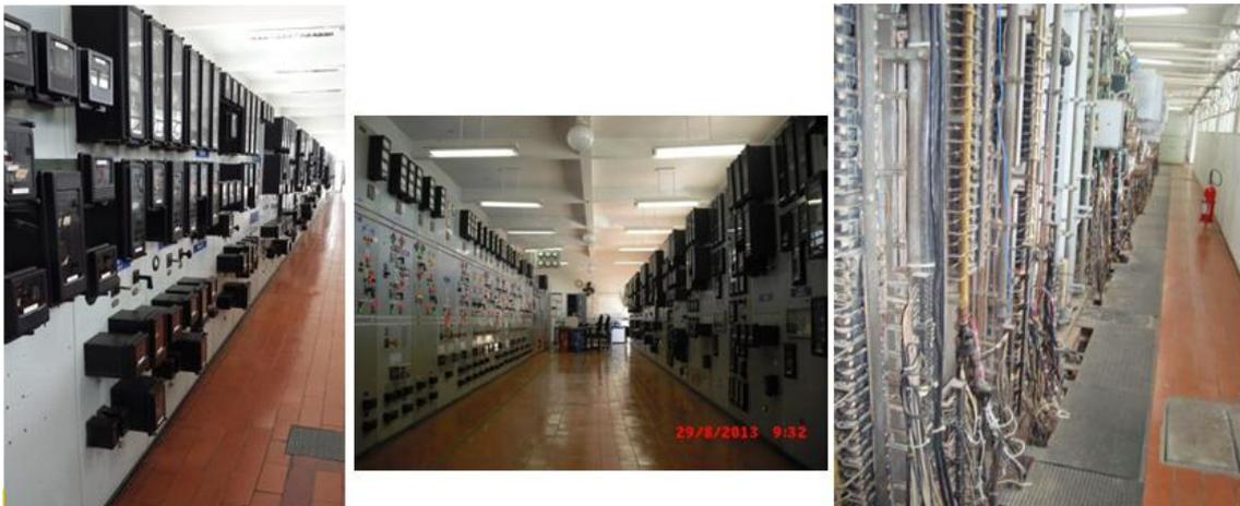
Já nas imagens abaixo, é possível verificar a nova sala de comandos que foi construída utilizando menos espaço, abrigando os painéis de proteção e controle. Os novos painéis possuem menor quantidade de cabos e são interligados por fibra óptica, realizando a comunicação por protocolos. Desta forma, o técnico da SE possui a supervisão de toda a instalação por meio de sistema supervisorio onde recebe alarmes, verifica estado dos equipamentos e realiza comandos.
